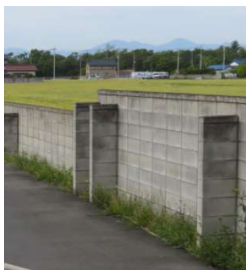
以前の フェンス
