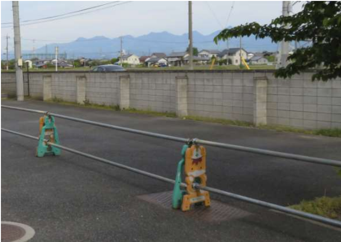
○古いフェンス
